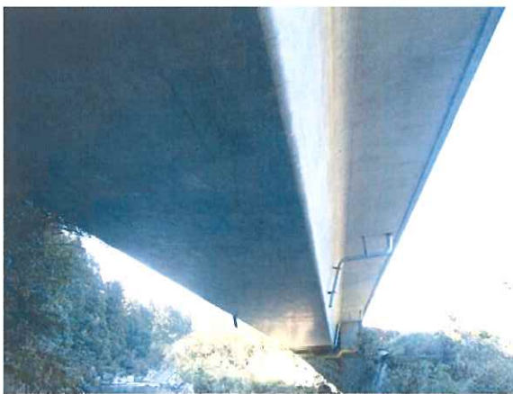
橋長の長い橋の例（皆尾大橋）
