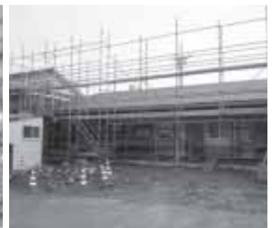
三原中学校 特別支援教室等建築工事
