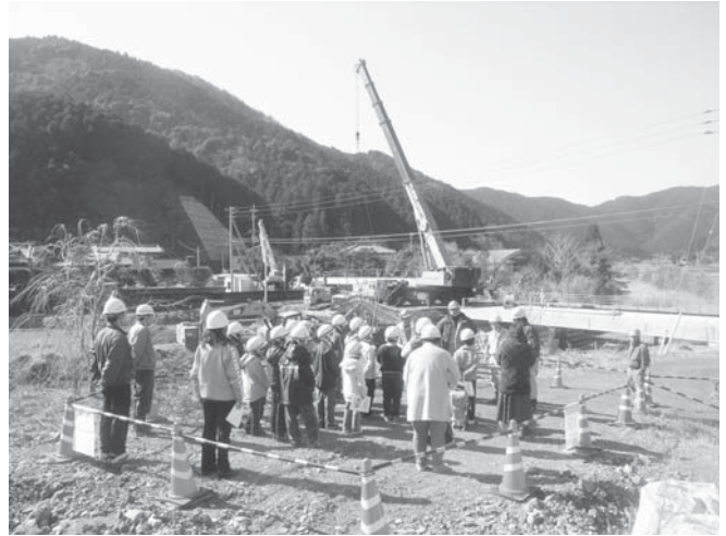
160トンの大型クレーンを見ながら、 見学会が始まりました
