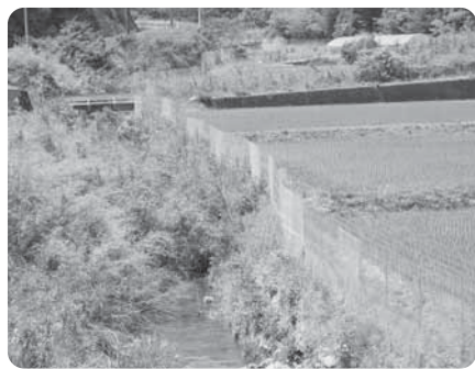
獣害防止金網設置状況
