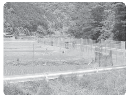
獣害防止金網設置状況
