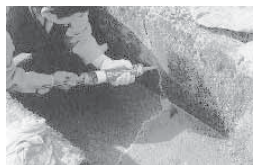
水路のひび割れ補修
