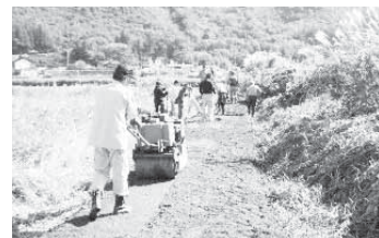
未舗装の農道をアスファルトで舗装
