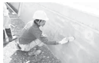
老朽化した水路壁のコーティング
