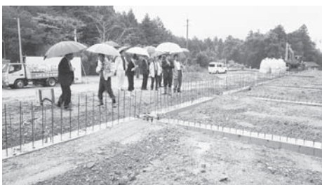
ユズ工場建設現場を総務委員会で視察
