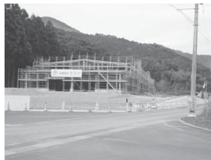
ユズ工場建設の状況
